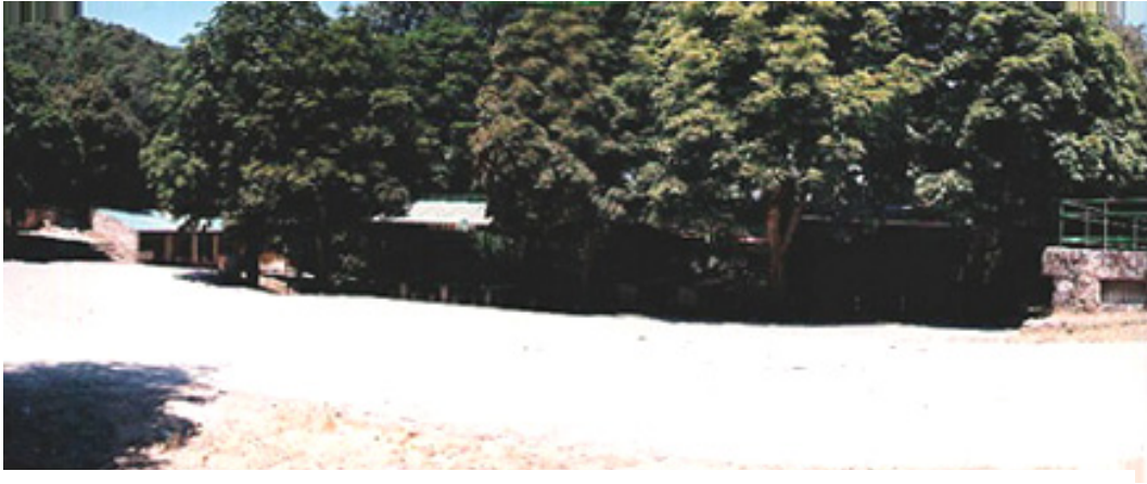
Casetas de la Laguna protegidas por los Castaños de Indias
