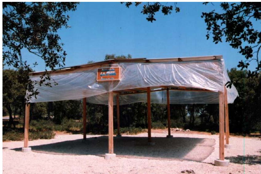
Caseta nº 73: La Pava (recientemente sustituida por nueva construcción)
