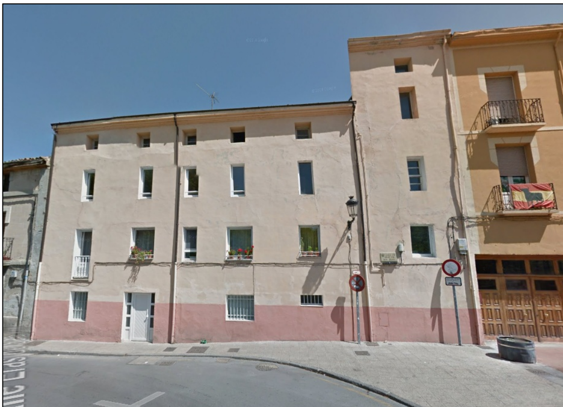
Vista del edificio desde Calle Eras de San Juan.
