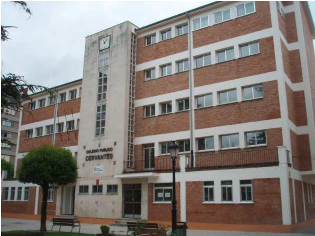
El antiguo colegio tiene deficiencias de aislamiento térmico, la cubierta está envejecida con goteras y canalones obsoletos. La instalación de calefacción es eléctrica con un rendimiento muy bajo. Las carpinterías son de aluminio con acristalamiento simple. El edificio no es accesible a personas con movilidad reducida.
