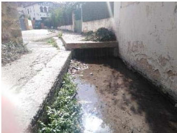
*Fotografía de la zona donde el canal pasa de cielo abierto a soterrado, a la altura del comienzo de la calle*
