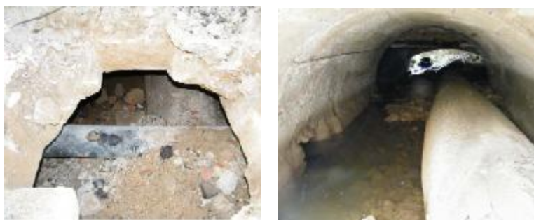
Canalización del cauce al atravesar la calle Real Aquende junto a la Torre
