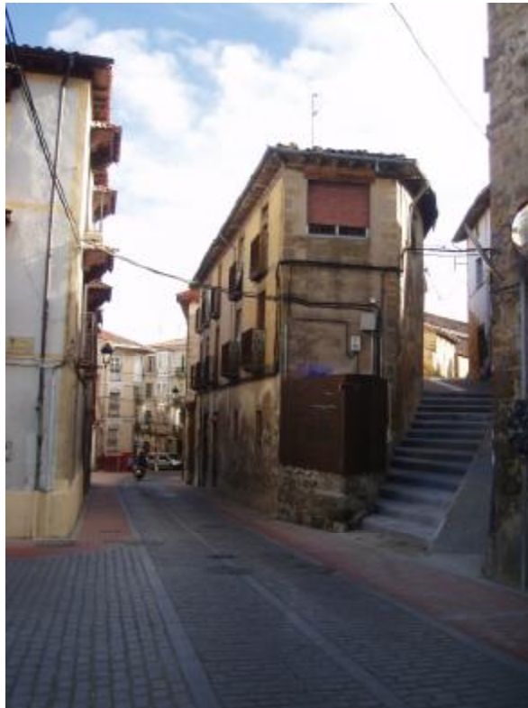
Ubicación de la Torre de entrada a la ciudad
