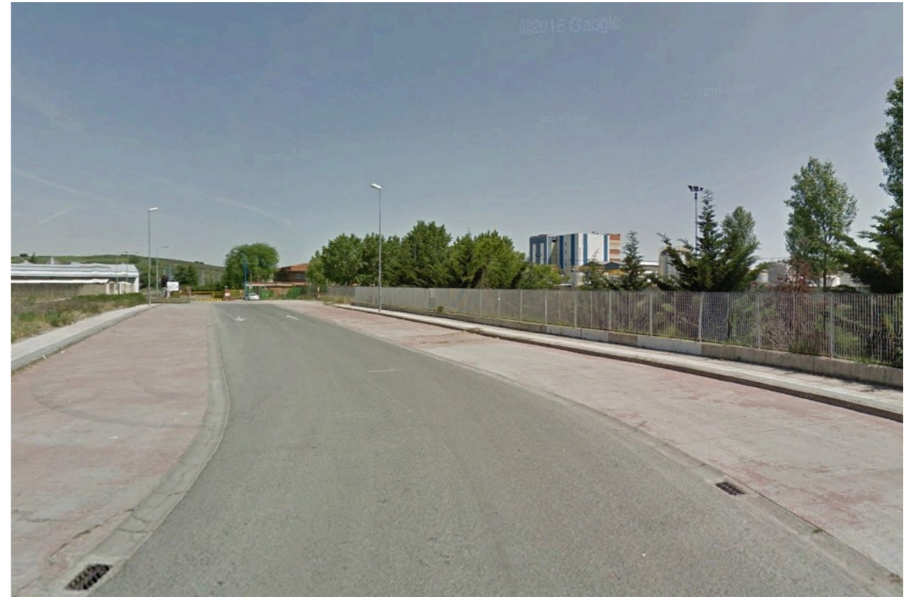
Figura 43: Acceso a complejo industrial
