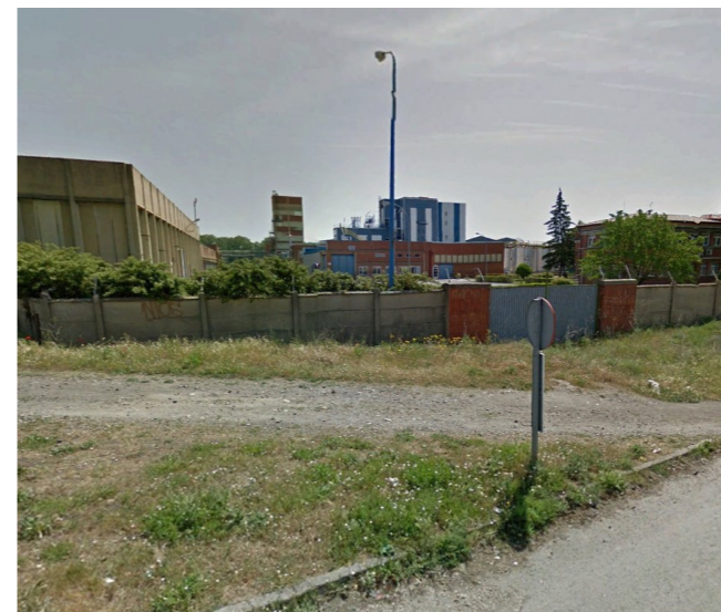
Figura 44: Vista complejo industrial
