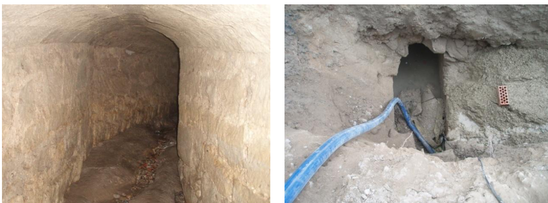
Desagüe de las Tenerías que atraviesan la calle Independencia
