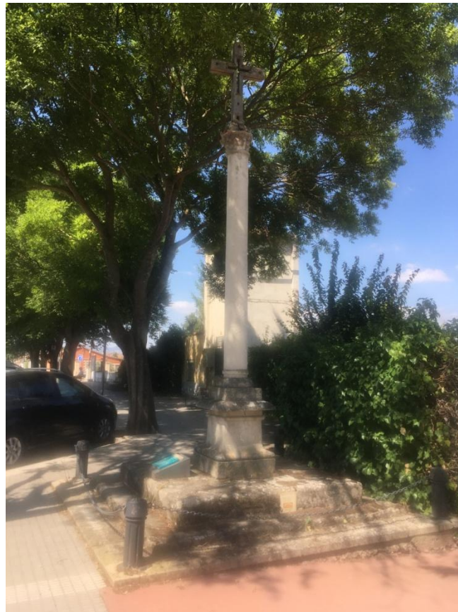
Situación actual del Crucero de la Carretera de Orón
