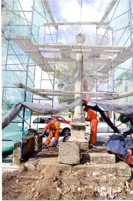
Remodelación realizada por la Escuela Taller en 1995 (A.M.M.E.Fondo Fotográfico AF09314)
