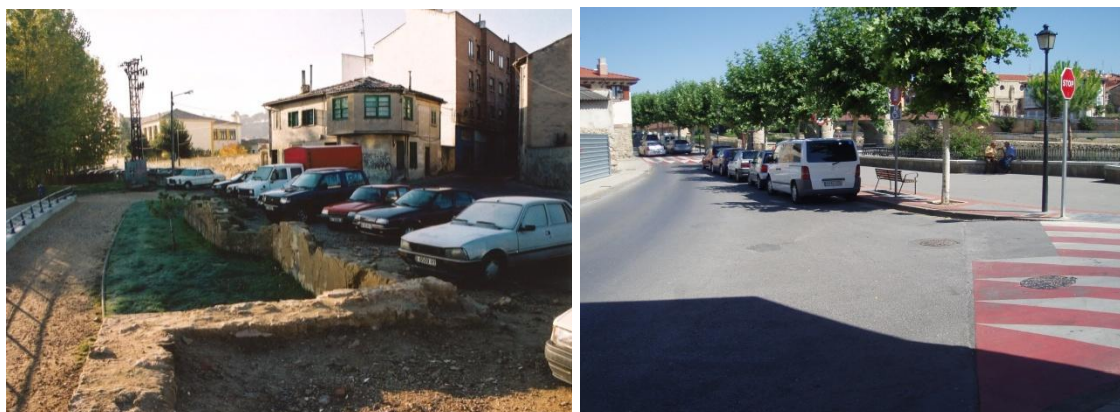
Estado tras la demolición
