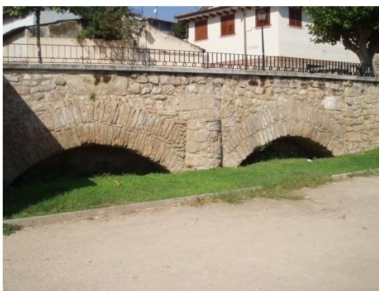
Desagüe de las Tenerías del Valle
