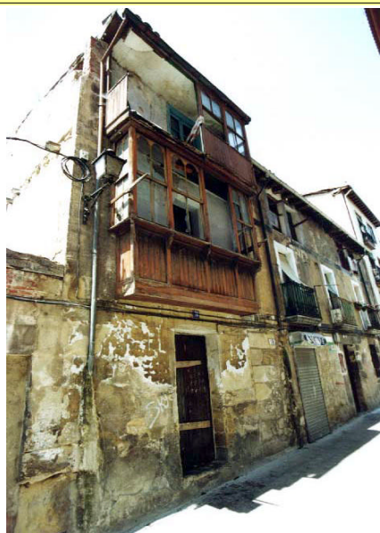
Fachada a la calle del Olmo
