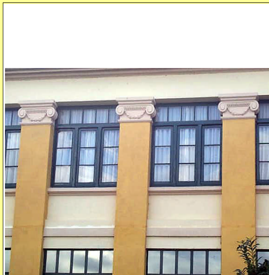
Detalle de Pilastras y Carpintería
