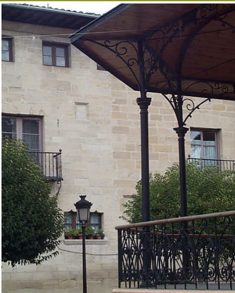
Detalle del pilar y barandilla
