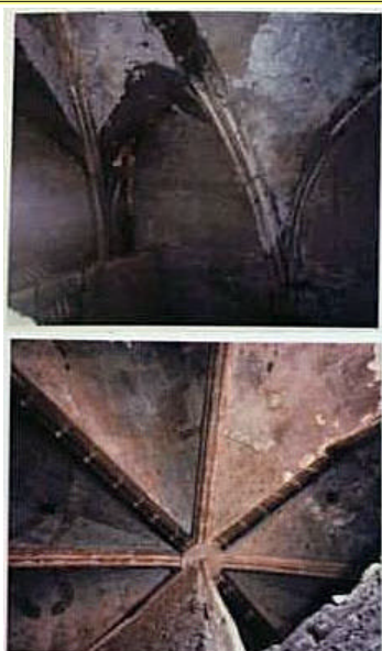
Detalle de Bóvedas
